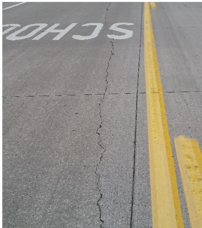
**c. Longitudinal cracking due to late sawing**
