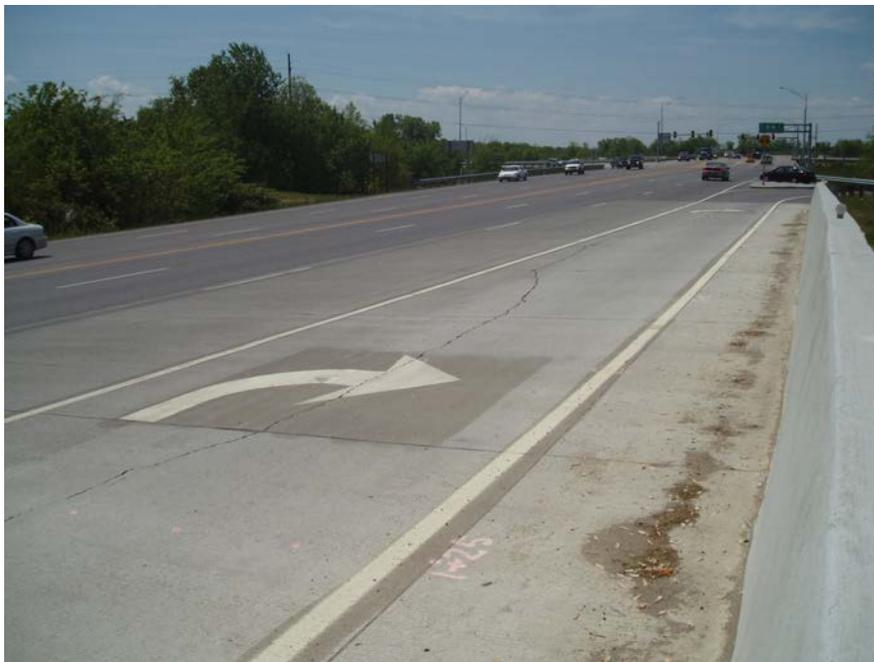
**a. Longitudinal cracking due to nonuniform support**
